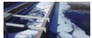
排水路・貯水槽の改修
