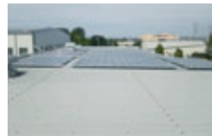
屋上自然力応用遮熱シートの導入
