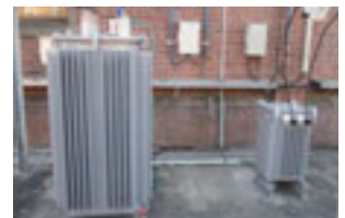
アモルフラス変圧器に更新
