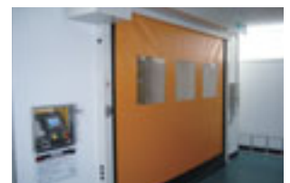
昇降機出入口へのシャッター取り付けによる室内空調の効率化
