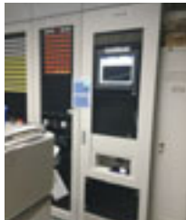
デマンド制御装置 (中央監視盤)
