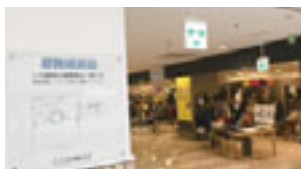
館内のLED誘導灯
