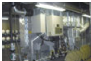
熱源機の更新
