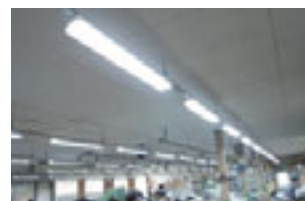
LED照明の導入
