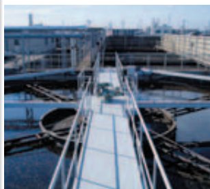
排水処理設備
