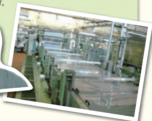
機台に保温カバーを設置
