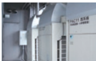
更新した空調機
