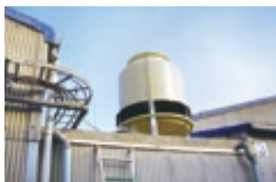
更新したクーリングタワー
