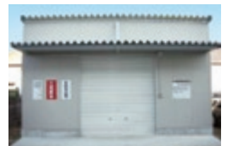
PCB保管倉庫
