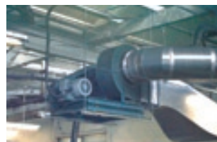
燃糸室の排気ダクト
