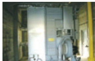
ガス吸収式冷凍機
