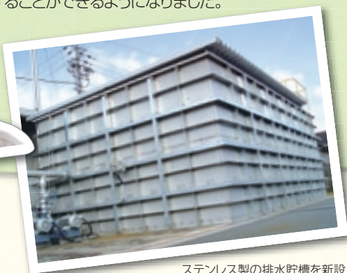
ステンレス製の排水貯槽を新設
