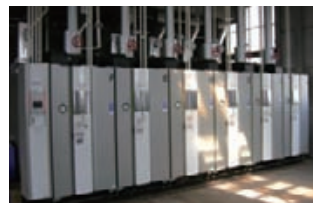
更新したボイラ
