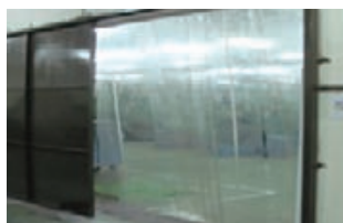
外気遮断用シートを設置
