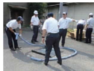
排水汚泥配管破損時の対応訓練 (印南工場)
