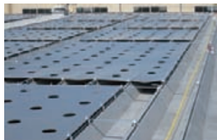
屋上に断熱シートを設置
