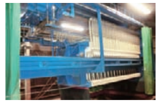
汚泥の脱水機の更新
