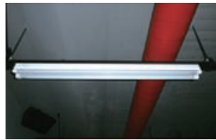
LED蛍光灯へ切り替え
