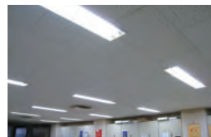
LED照明の導入
