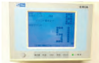
使用電力監視システム
