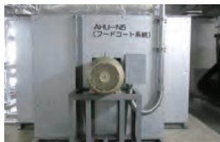
空調機の更新
