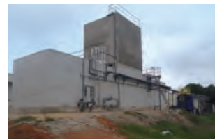
廃液を処理する生物処理設備
