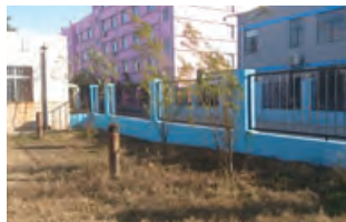
塀を設置し環境安全確保
