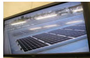
発電状況がわかるパネル
