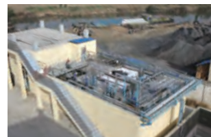
汚水処理設備を稼働
